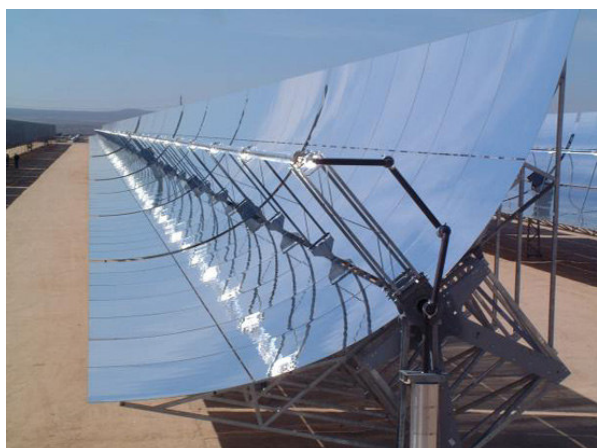
Un collecteur cylindro-parabolique d'une centrale solaire.
