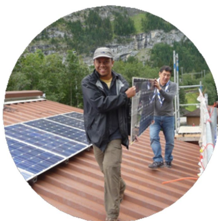
Instala un sistema fotovoltaico
