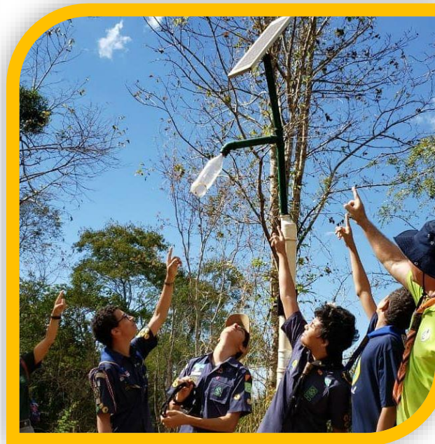
Poste Verde Solar
