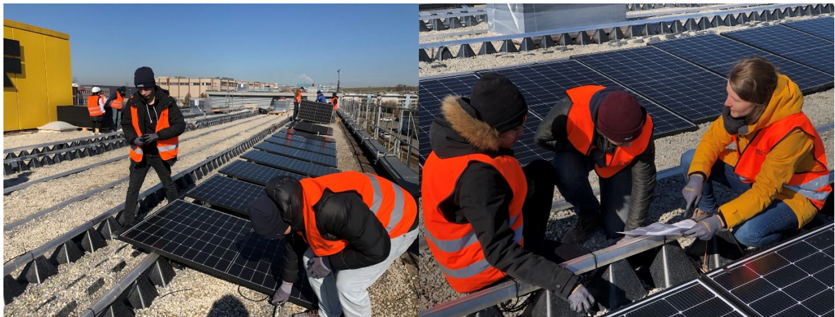
Auf einem Flachdach installieren Jugendliche, unter Anleitung von Fachleuten, eine Solaranlage. Anhand des Schemas wird überprüft, ob die Panels richtig miteinander verkabelt sind.
