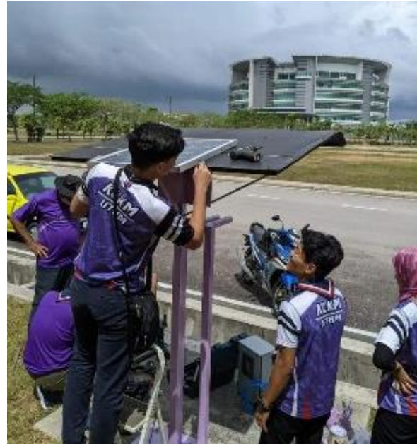
Bild 17: Installation der Solarpanels auf dem Dach über dem Luftkompressor, Juni 2022
