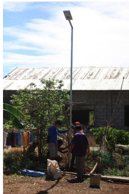
Bild 3: Pfadis und einheimische Jugendliche installieren gemeinsam eine Solar-Strassenlaterne, Januar 2022
