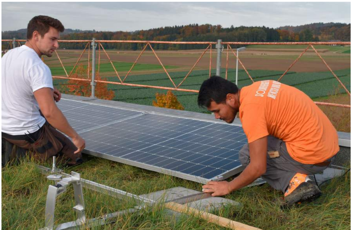
Participant Latif assembling a solar module.
