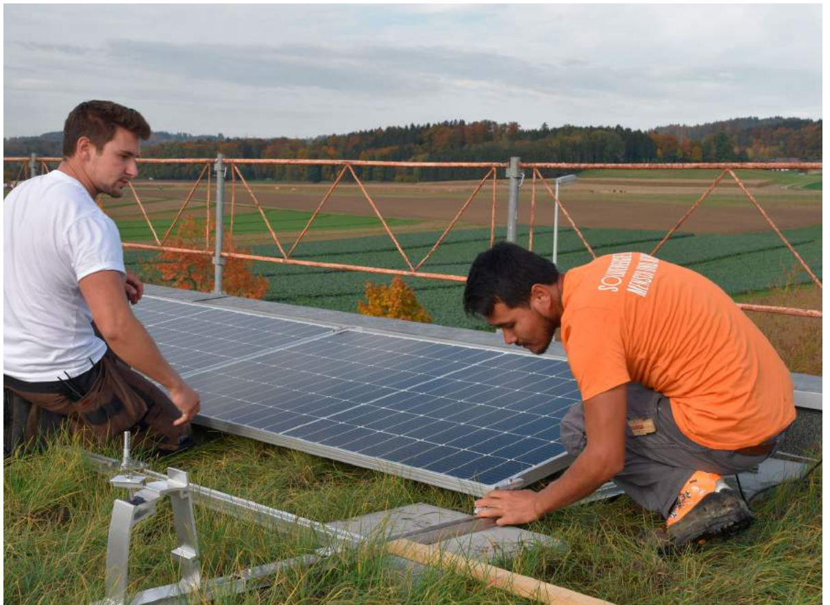
Teilnehmer Latif bei der Montage eines Solarmoduls.
