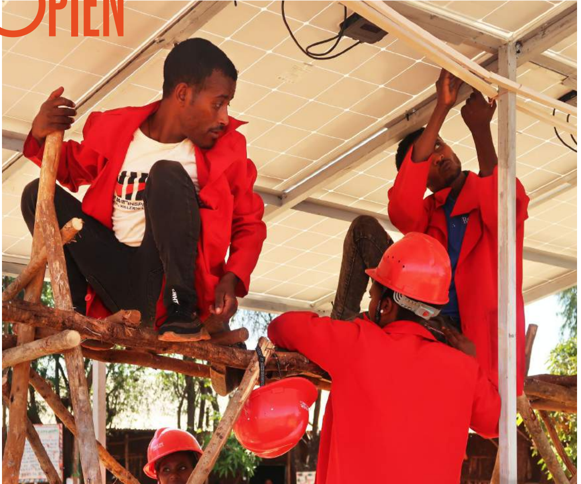
Auszubildende installieren eine PV-Anlage für eine Primarschule in Togedro ausserhalb von Bahir Dar, Äthiopien.
