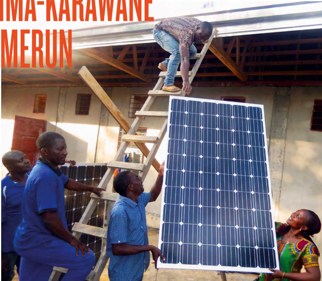
Installation einer Solaranlage auf einem Gesundheitszentrum in Kamerun.
