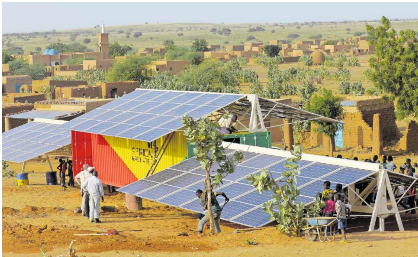
«Ikea der Energie»: Ein Solar-Container versorgt das Dorf Amaloul in Niger, am Rande der Sahara, mit Strom. (September 2017)
